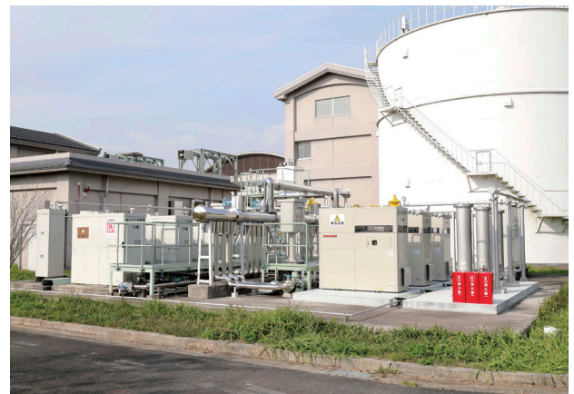
図13 木津川上流浄化センター消化ガス発電設備
