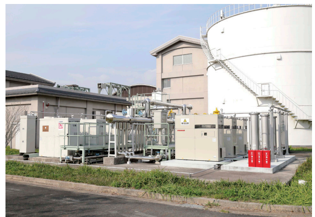
図13 木津川上流浄化センター消化ガス発電設備
