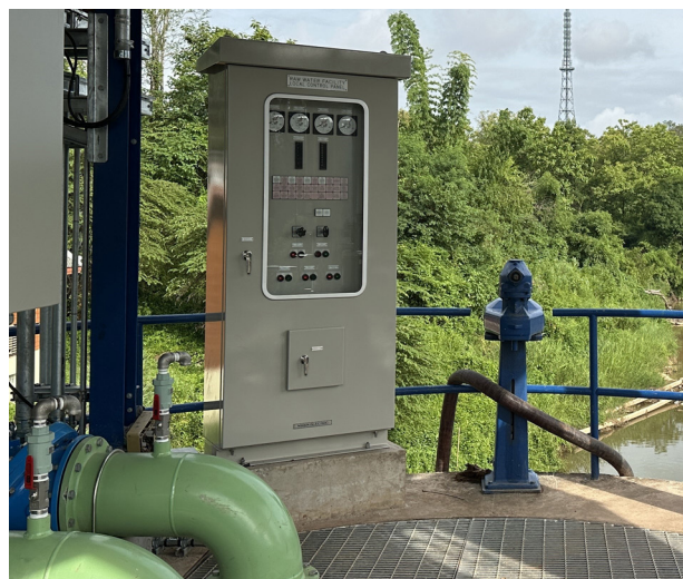
図2 低圧受配電設備
