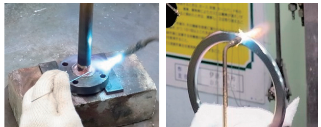
図4 銅パイプ、ブスバーへの銀ろう付け
