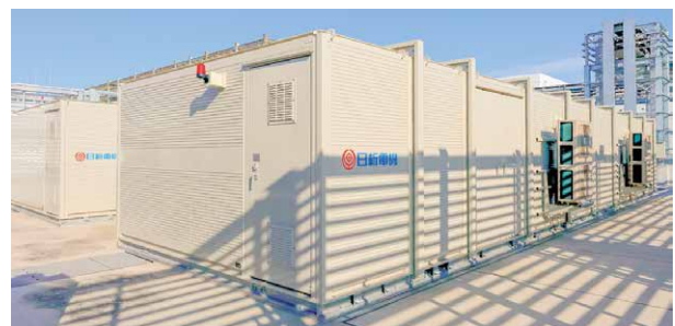
図3 アルミパッケージ式全天候形スイッチギヤ（AL-PAC）
