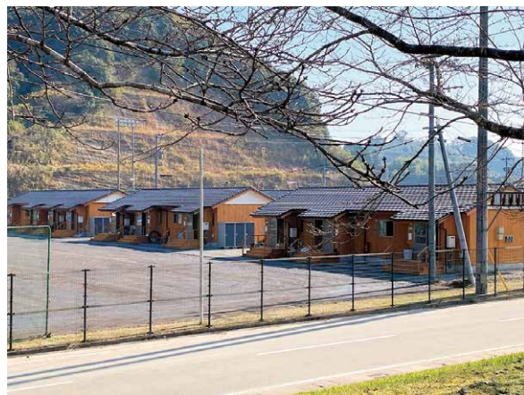
図2 A地区 建設型仮設住宅
