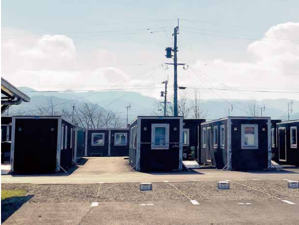
図3 B地区 建設型仮設住宅
