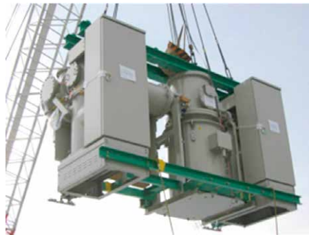
図16 VCTを接続したGIS搬入状況
