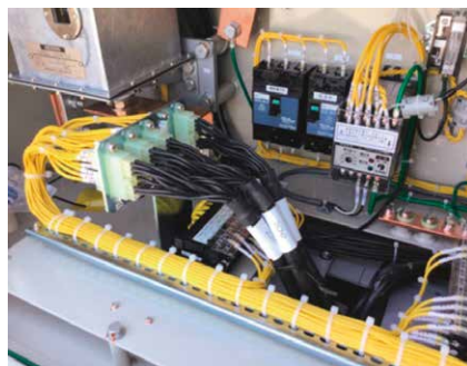
図19 コネクタケーブル適用の例 (GIS側)
