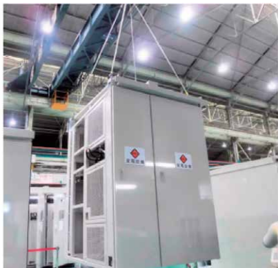
図17 高圧スイッチギヤ2面一括吊上げ状況
