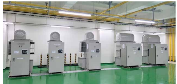
図1 ユニット形コンデンサ装置 univar
