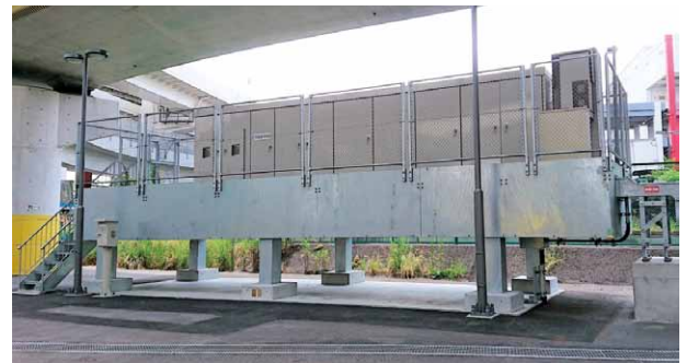
図1 環境配慮型（ドライエア）変電塔
