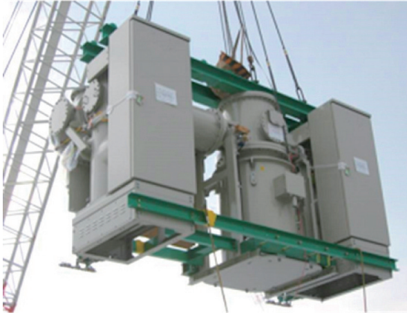
図21 VCTを接続したGIS一括搬入
