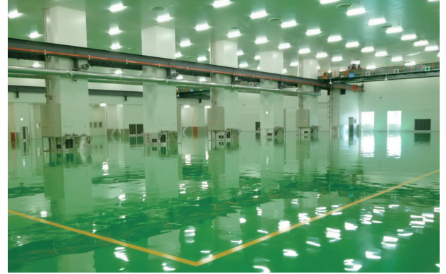
図5 滋賀事業所 クリーンルーム
