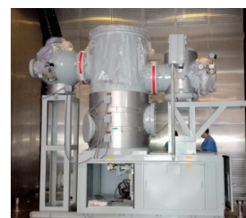
図6 耐寒試験状況
