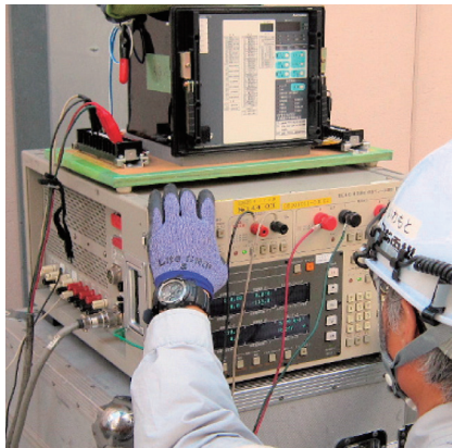
図3 従来の保護継電器の点検作業
