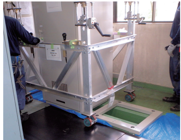
図6 タオレンゾーを使用した盤のオンベース状況
