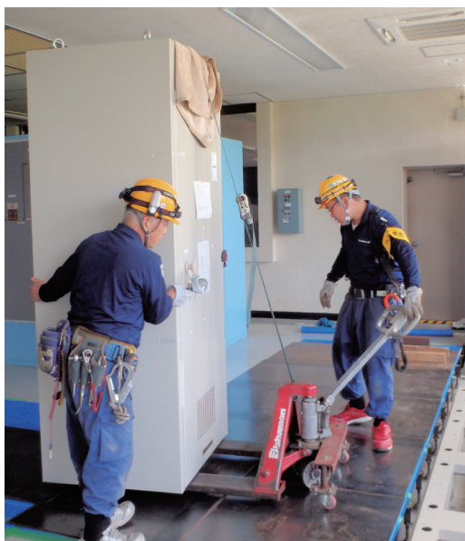
図2 ハンドリフターを使用した盤の移送
