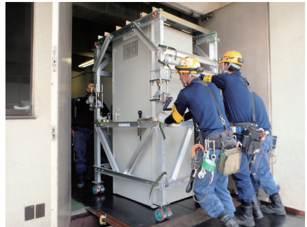
図5 タオレンゾーを使用した盤移送状況
