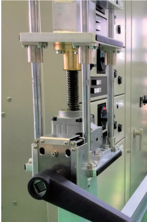
図4 タオレンゾーのジャッキアップ機構
