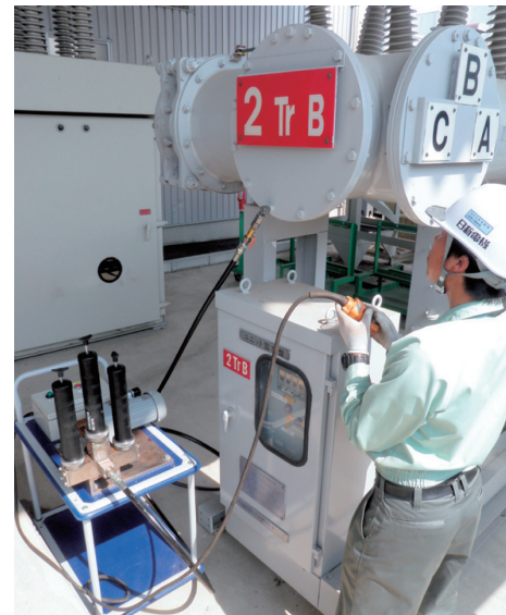
図2-3 シーラント充填の様子（電動シーラント充填装置）
