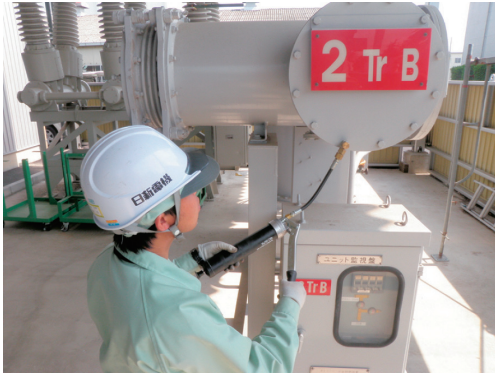
図2-1 シーラント充填の様子（手動ポンプ）
