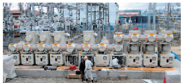
図2-4 GIS据付工事の例
