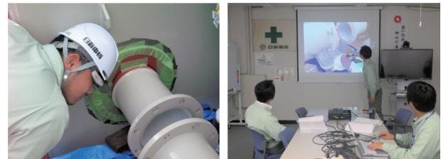
現場側にて画像を撮影 (写真は、配管接続部の品質確認) → 事務所側にて画像を確認 (写真は、スクリーンに投影された現場画像の確認)
