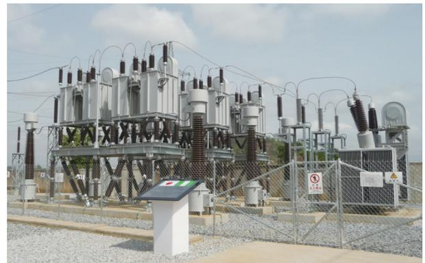
図1 アボ変電所納 132kVコンデンサ設備
