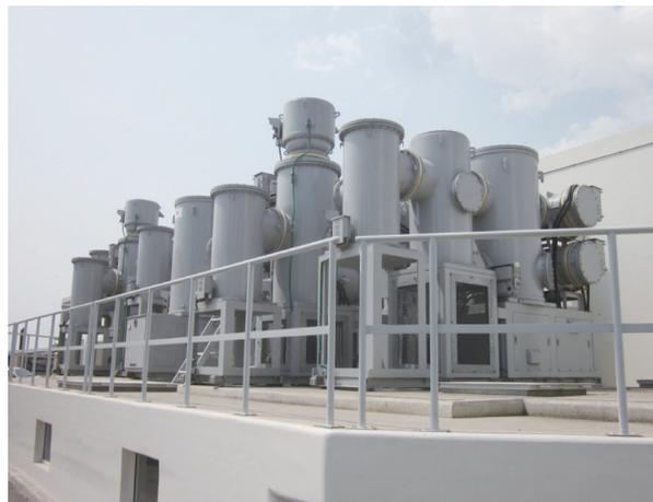
図2 161kVガス絶縁開閉装置
