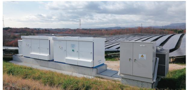
図3 22kV中間変圧器ユニット及び660kW PCS 201812④
