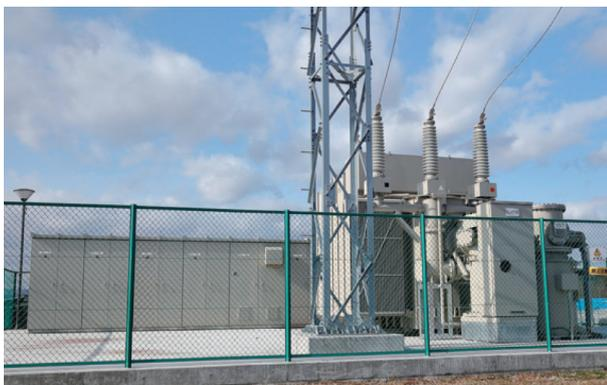
図2 66kV特高変電所連系設備 201812③
