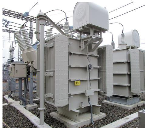
図2 不平衡補償装置用リアクトル
