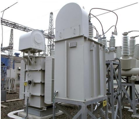
図1 不平衡補償装置用コンデンサ
