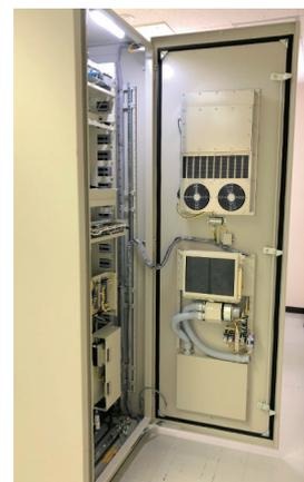
図4 腐食ガス対策盤
