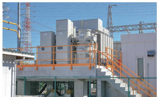
図1 77kVガス絶縁開閉装置 20189③
