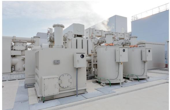
図4 ガス絶縁中性点抵抗器（左） 201813㉑
