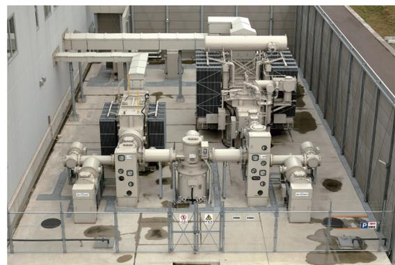
図5 66kV特高連系設備 201811㉒
