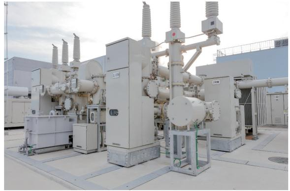
図3 66kV受変電設備 201813⑳
