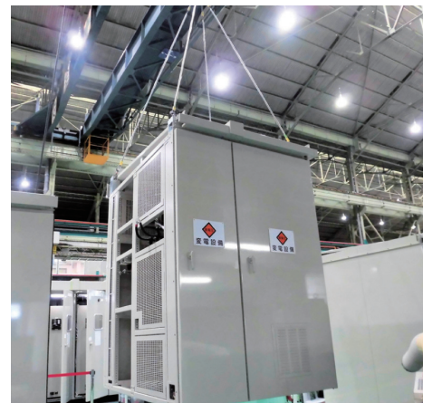
図26 高圧スイッチギヤ2面一括吊上げ状況
