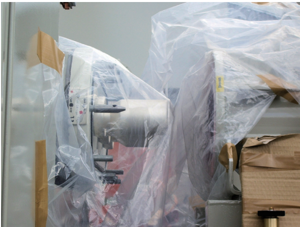
図24 現地でのガス母線接続作業
