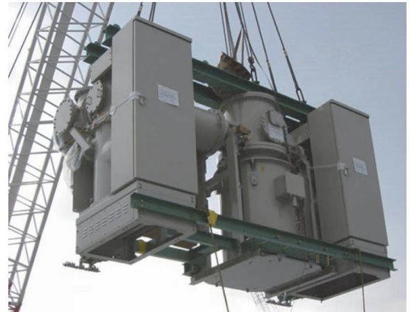
図25 VCTを接続したGIS搬入状況
