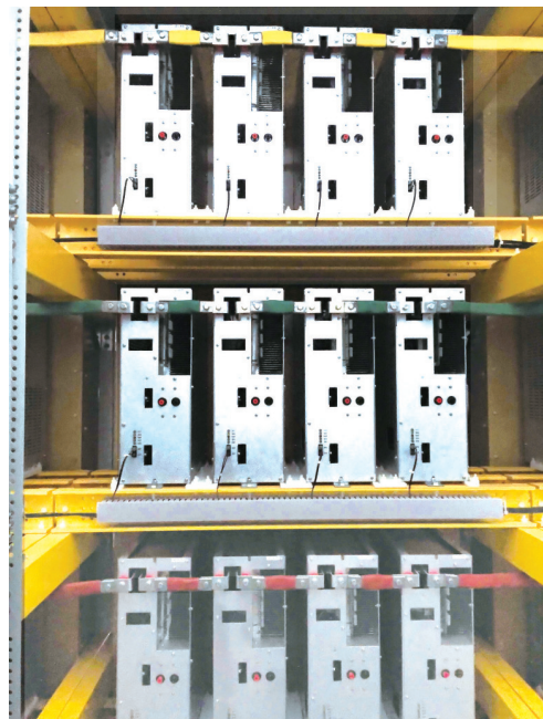
図4 インバータ盤内部構造
