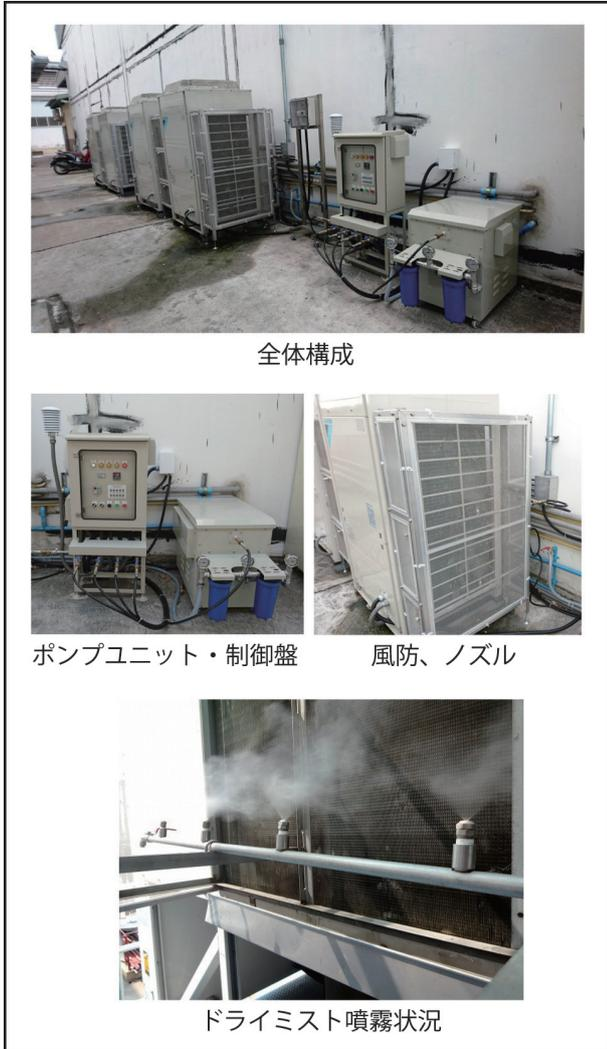
図1 HP POWER SAVING MIST UNIT外観
