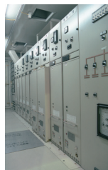
図2 固体絶縁 スイッチギヤ
