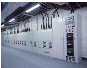
図1 SF 6 ガス絶縁 スイッチギヤ
