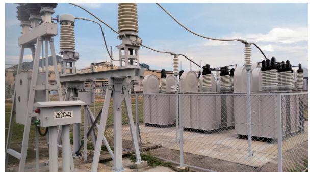
図1 タンク型コンデンサ設備
