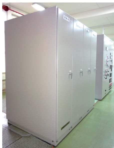
図3 縮小形ガス絶縁開閉装置（GIS）
