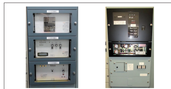
(a) ユニット交換前 (b) ユニット交換後
