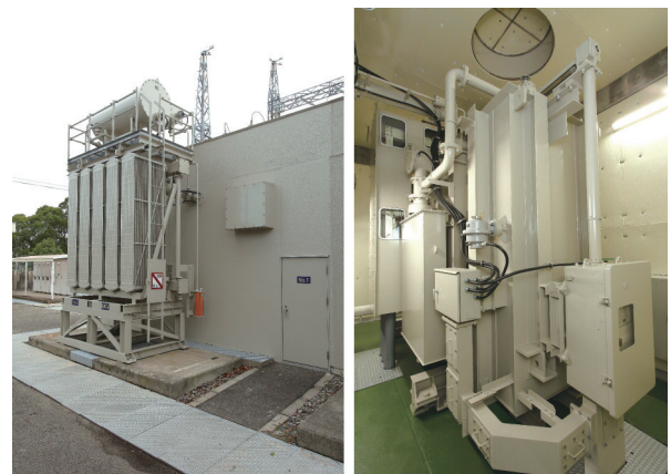
図4 (左:防音室外観、右:防音室内の本体設置状況)
