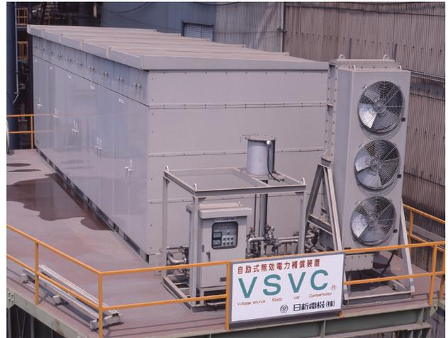
図5 某製鉄所向けVSVCの外観
