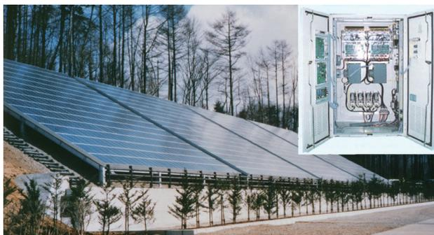
図8 某県企業局様100kW PVシステムとPCS (右上) 写真 949
