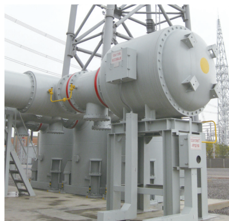
図11 ガスVTの生産台数推移とUHV用ガスVT
