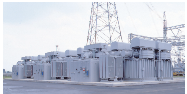
図2 縮小形SC設備用SR（147kV 80Mvar用 55dB）
