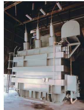
図15 変圧器（77/33kV 80MVA）
