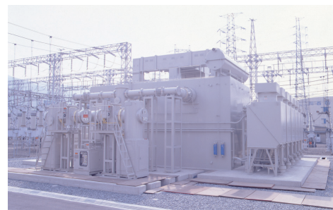
図23 高インピーダンス変圧器 (154/5kV 60MVA %Z=76)
