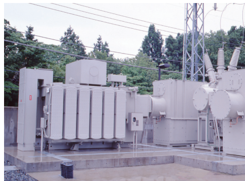
図18 GIS直結形変圧器（64.5/6.6kV 10MVA）
