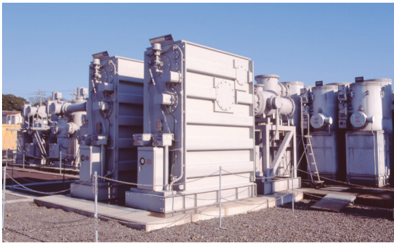
図12 ガス絶縁ケーブル補償リアクトル装置（GCR） （77kV 2.4MVA 15秒）
