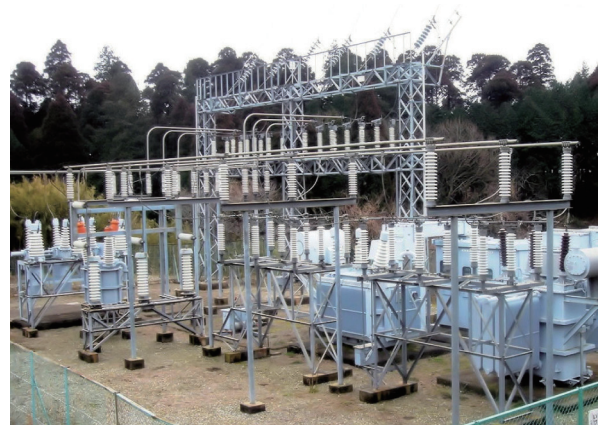
図 3.1.14 66/77kV屋外開放形設備
