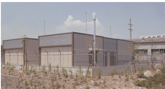
図 3.3.1 77kVパッケージサブ PI332②
