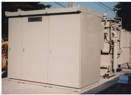
図 3.3.5 全地中地域用6MVA配電塔 99102
