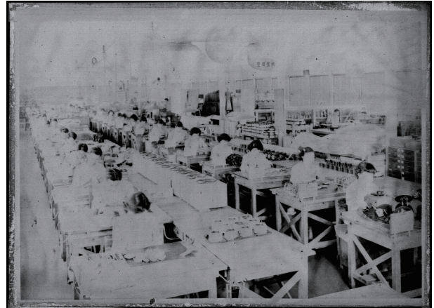
図 2.2.4 計器組立工場
