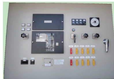
図 3.4.1 22kV Var V クラッド用デジタル形調相用保護継電器
