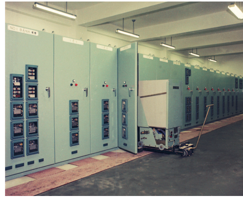
図 3.1.8 3/6kV磁気遮断器収納閉鎖形配電盤 115②
