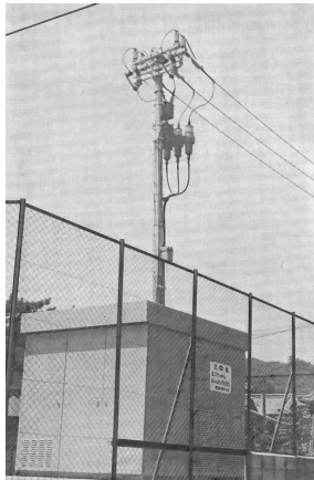
図 3.2.6 22kV配電塔
