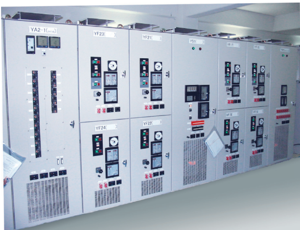
図 3.4.3 新縮小形6kV屋内スイッチギヤ
