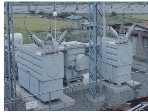
図 3.3.18 66kVオールインワン形GIS (A-GIS)
