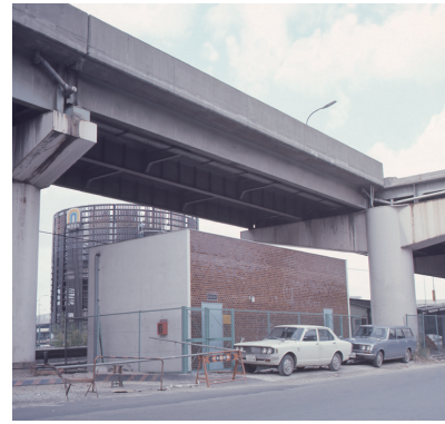
図 3.2.7 22kV都市形配電塔
