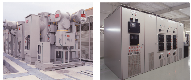
(ガス絶縁開閉装置(GIS)) (6kVスイッチギヤ)
