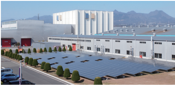
図 4.2.1 太陽光発電システム
