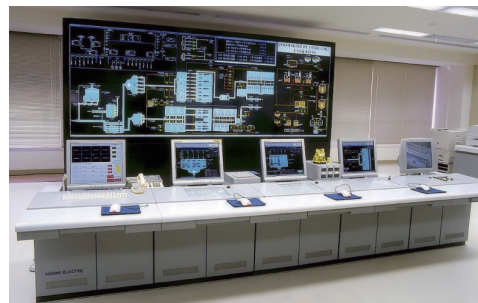
図11 水処理監視制御システム
