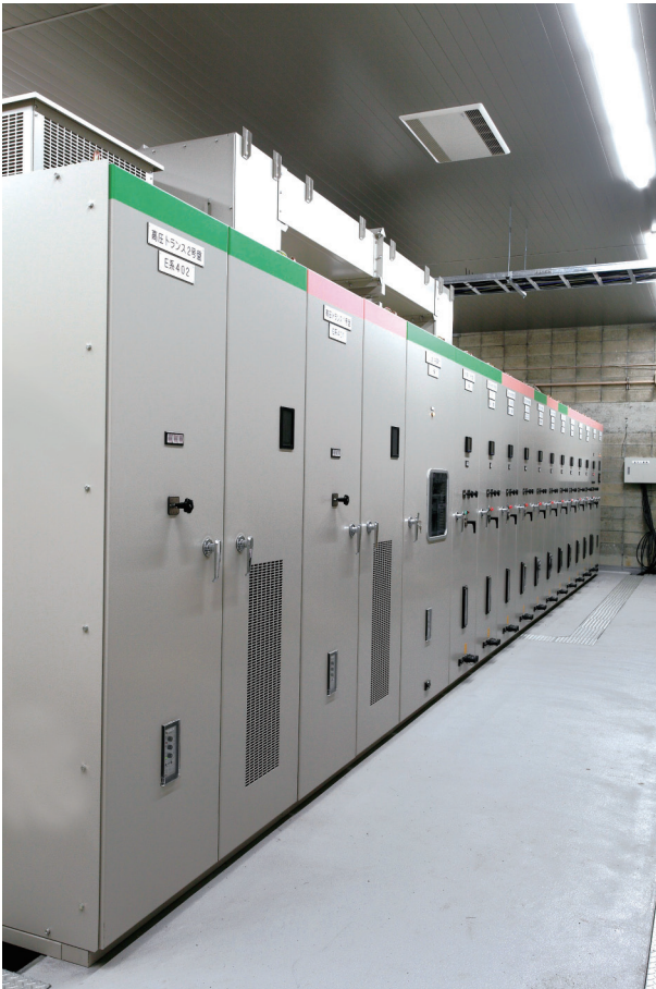
図2 6kV保守最適形高配盤 201417③
