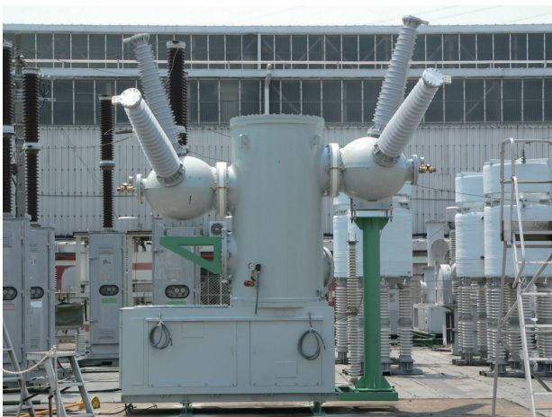
図8 連続開閉試験状況
