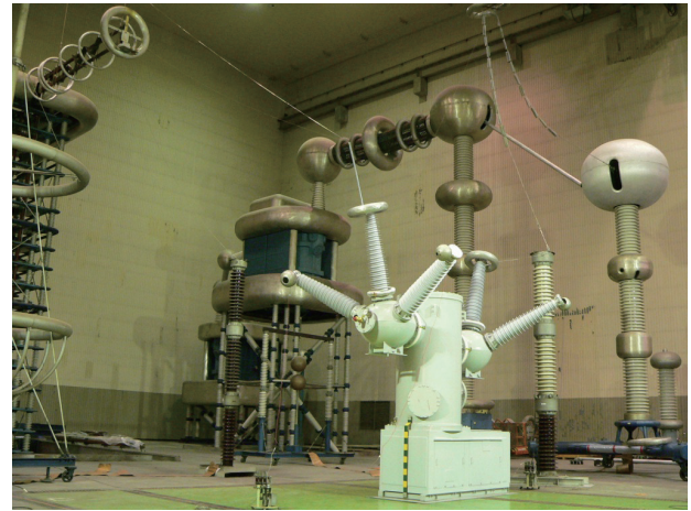
図9 耐電圧試験状況
