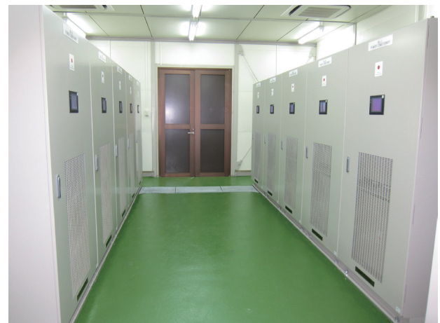
図2 100kWパワーコンディショナ
