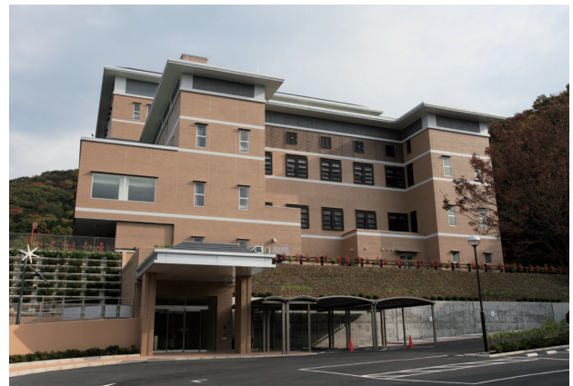
図 4 はだのクリーンセンター 外観 20128
