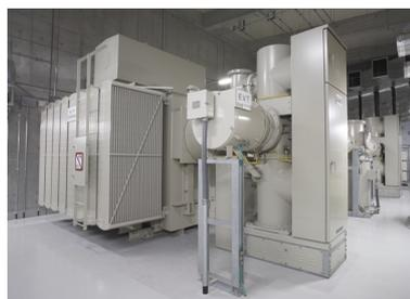
図2 77kV受変電設備 201110
