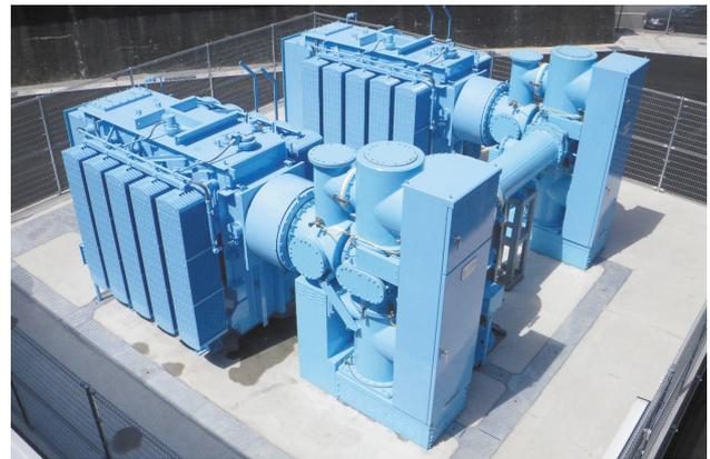
図4 77kV受変電設備
