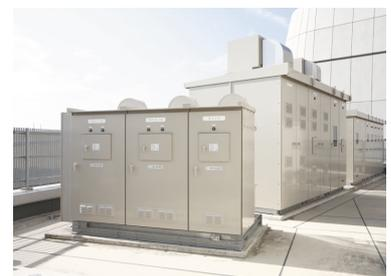
図3 ユニット形コンデンサ及び高速限流遮断装置 201110
