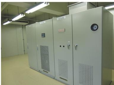
図2 集電箱(奥)・パワーコンディショナ(中央)・系統連係盤(手前)
