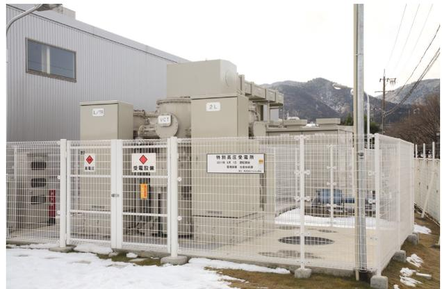
図3 77kV受変電設備
