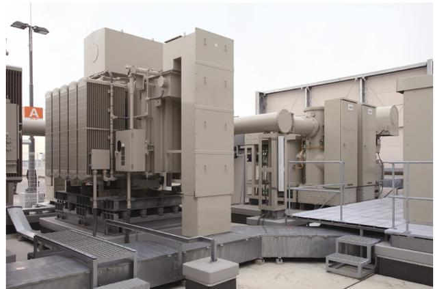
図2 66kV受変電設備
