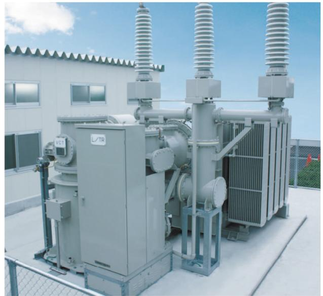
図4 66kV受電設備
