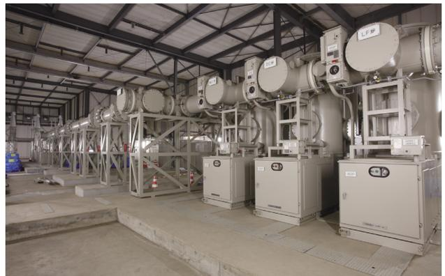
図1 154kVガス絶縁開閉装置
