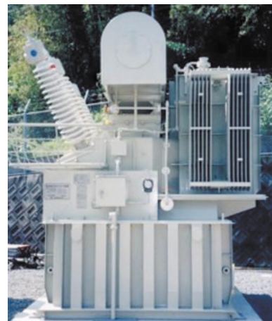
図17 特別高圧回路用ユニット型コンデンサ設備 (66kV 10Mvar)
