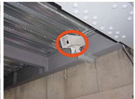
屋内天井から撮影
