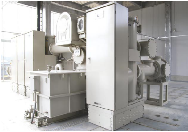
図6 72kV超縮小形ガス絶縁開閉装置（さくら新研究所殿）
