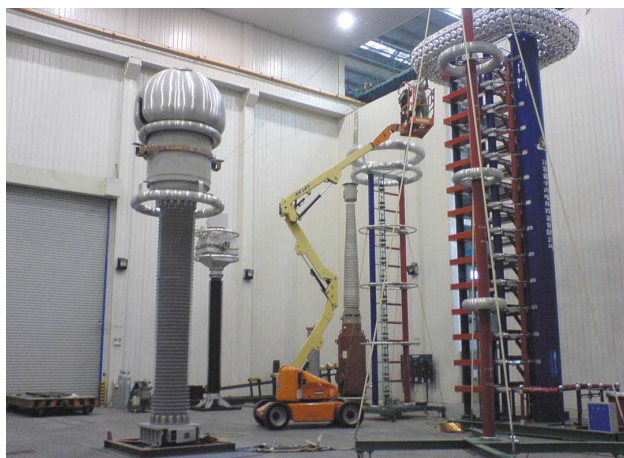
図9 ガス絶縁倒立形CT型式試験状況
