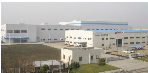
図5 NEW新工場全景
