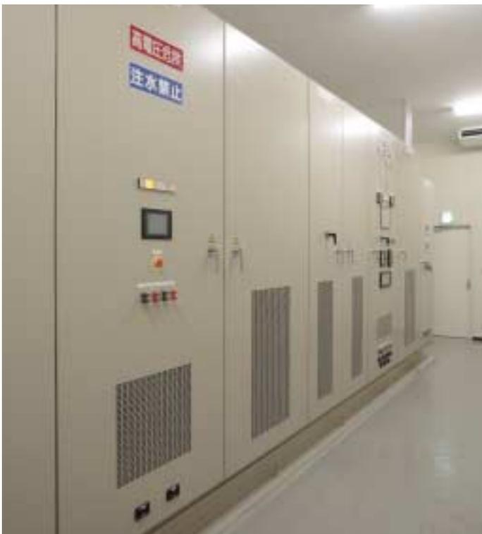
高圧用瞬低停電対策装置（パワーセーフ）
