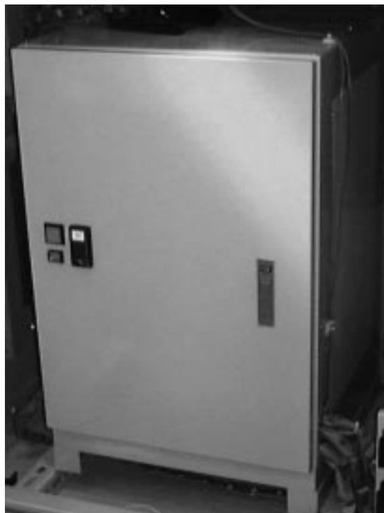
図 5 単独運転検出装置 (黒川風力発電所設置)
