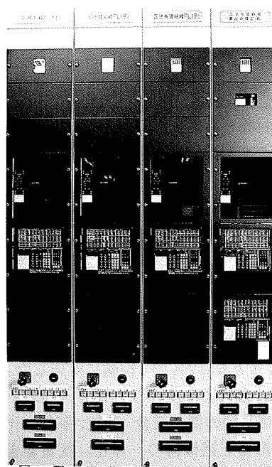
図22 多端子式故障点標定装置
