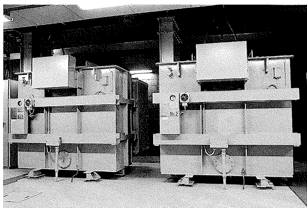
図3 22 kV ガス絶縁変圧器 (京都新聞社殿)
