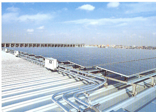
84kW 太陽光発電システム (本文28ページ)
