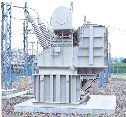
66kV 5Mvarユニット式 電力用コンデンサ設備 (本文9ページ)
