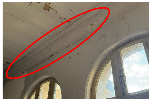
2 階天井廻り縁の亀裂
