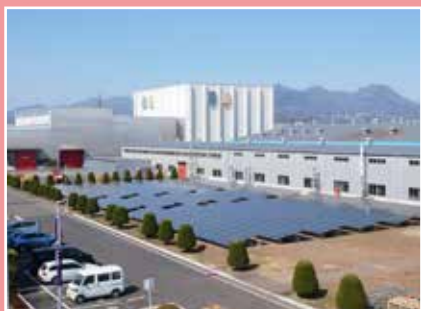
太陽電池(地上設置)
